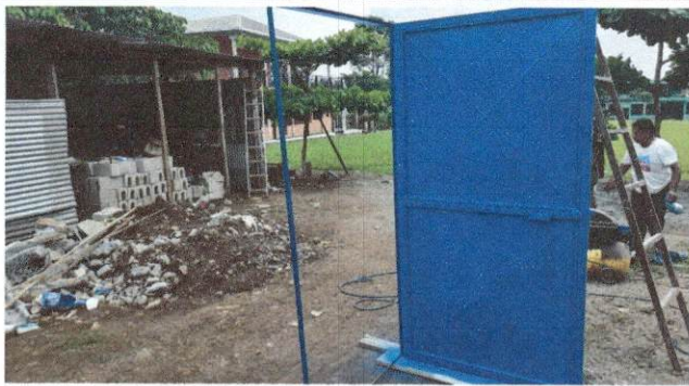
Foto 3: Sustitución de Puerta
