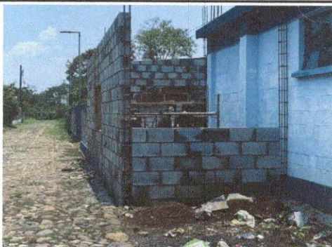
Foto 5: Pintura en Muros Exteriores e Interiores, Reparación de muro perimetral de block y repello en muro.
