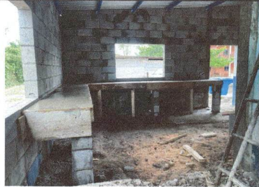
Foto 4: Sustitución de Piso
